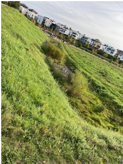
Versickerung zwischen den Häusern
